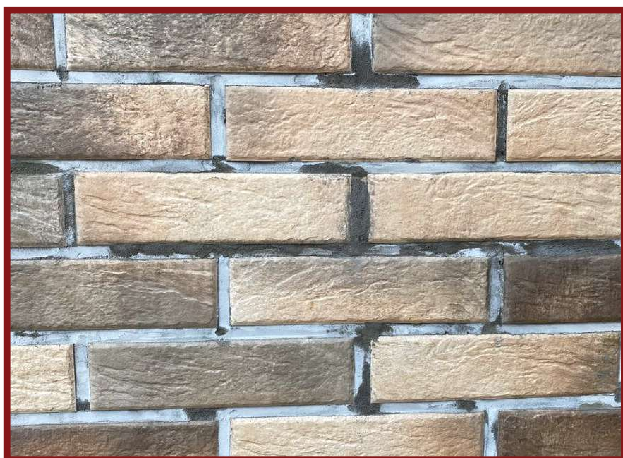
Расшивку выполняли по сырому материалу, заглаживая шов, смачивая инструмент
